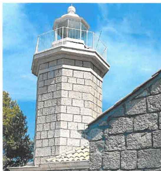
Slika 3. Pomorski svjetionik Daksa - nakon sanacije
