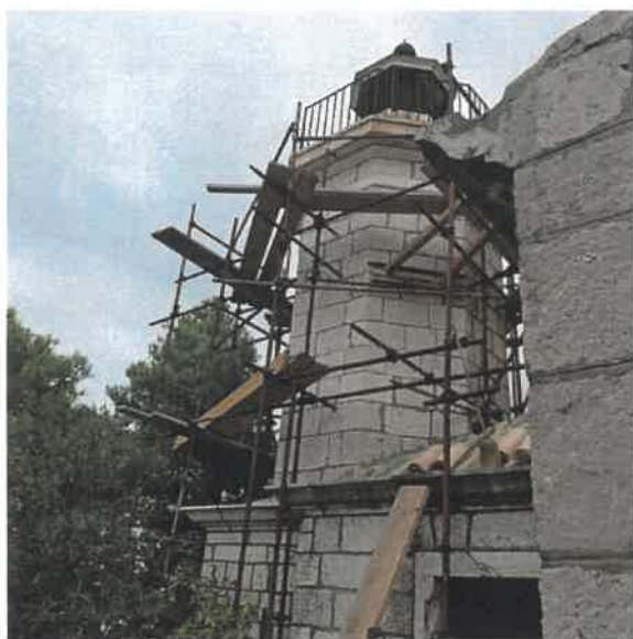
Slika 2. Pomorski svjetionik Daksa – radovi sanacije
